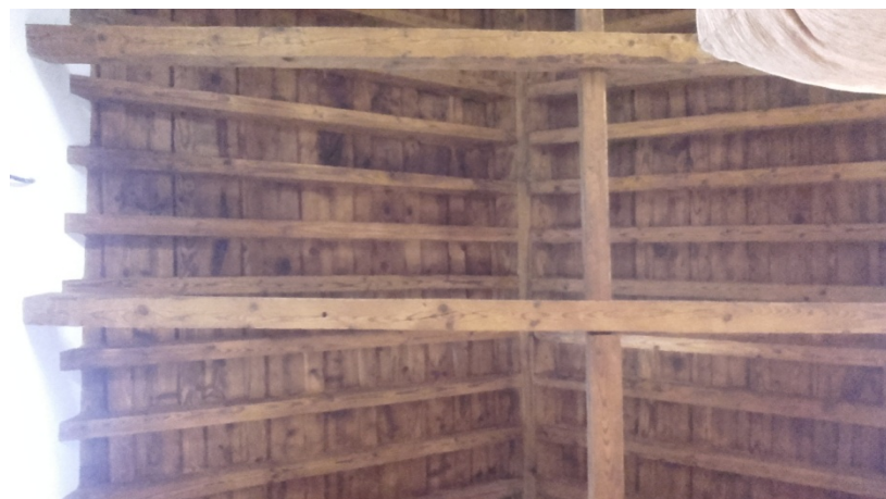
Crujía norte: tramo principal
