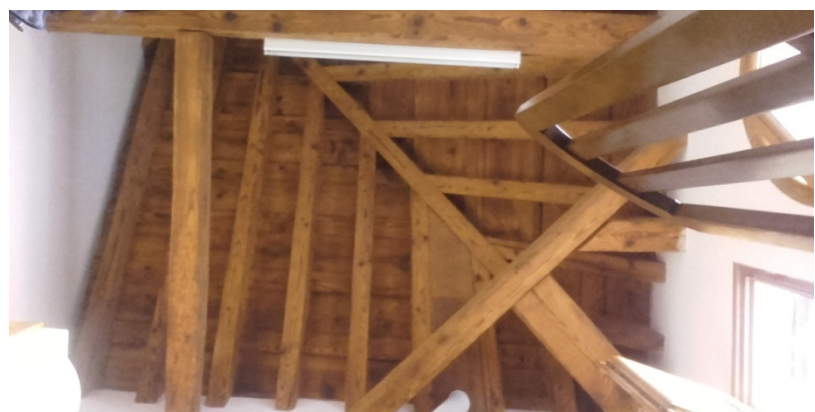
Crujía norte: encuentro medianera oeste.
