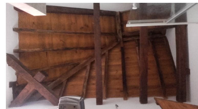
Crujía oeste: encuentro con patio 6
