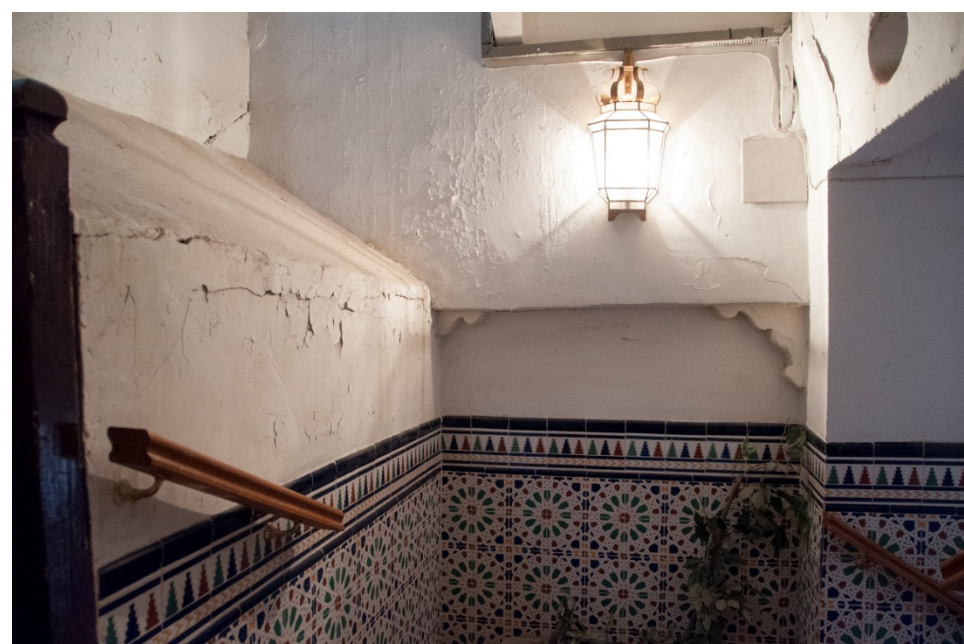
Arranque junto a patio
