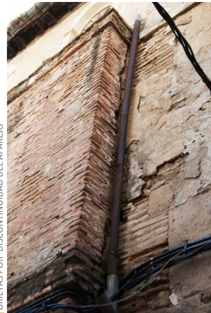
GRIETAS POR DISCONTINUIDAD DEL APAREJO
