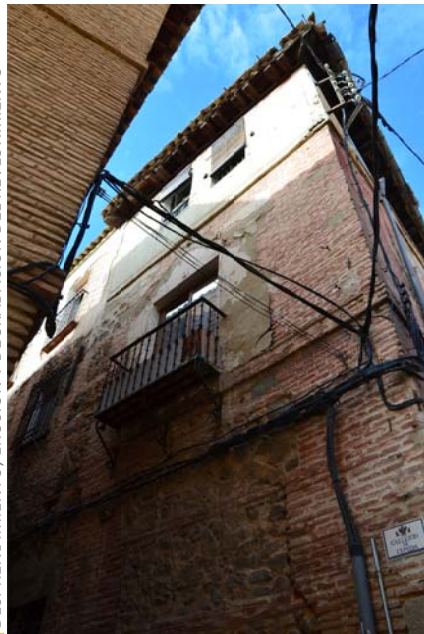
DESPRENDIMIENTO, EROSIÓN Y DEGRADACIÓN DEL REVESTIMIENTO
