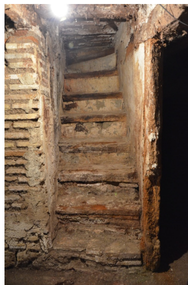
Escalera a patio 8
