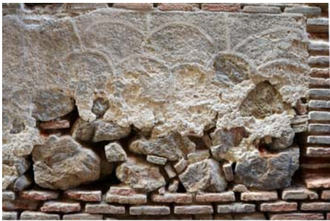
PÉRDIDA DEL REVOQUE ORIGINAL
