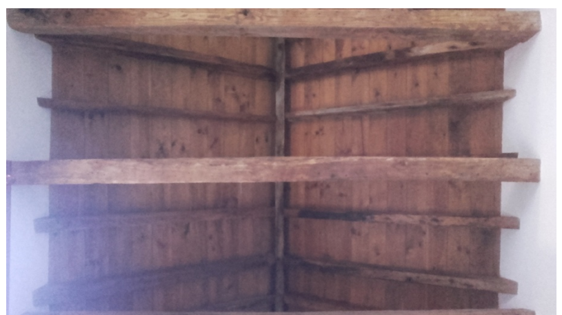
Crujía oeste: tramo principal
