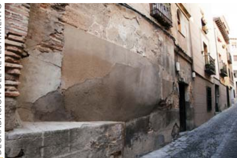
DEGRADACIÓN DEL REVESTIMIENTO
