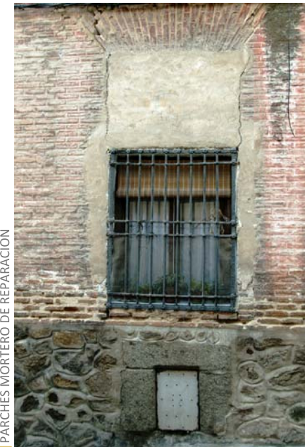
PARCHES MORTERO DE REPARACIÓN
