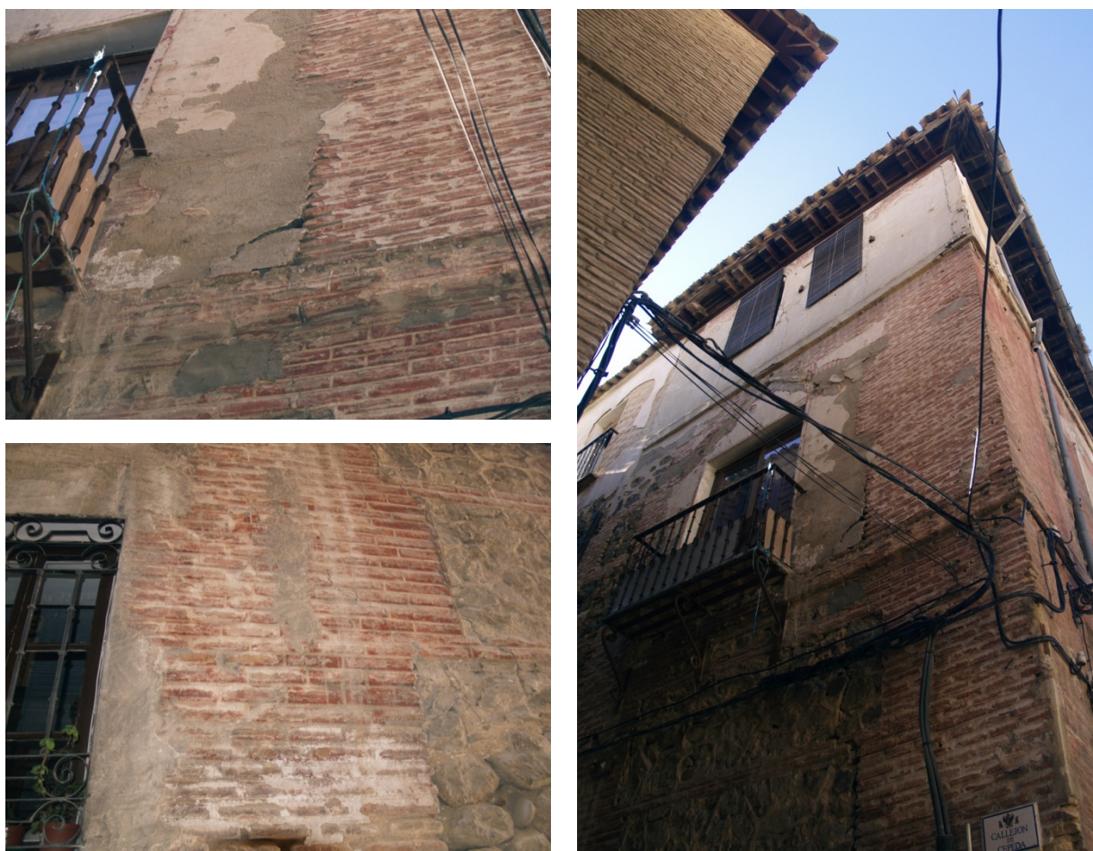
Una grieta por discontinuidad constructiva cruza parte de la fachada en la esquina de la calle Cepeda.
