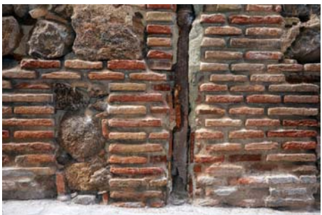
ROTURAS EN EL CERRAMIENTO
