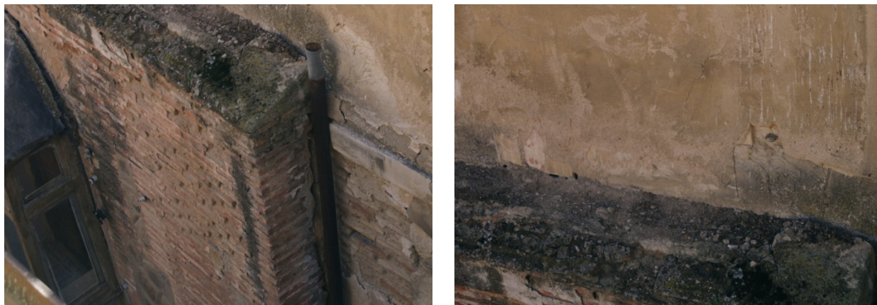
Una grieta por discontinuidad constructiva cruza parte de la fachada en la esquina de la calle Cepeda.
