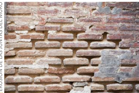
EROSIÓN DE LAS JUNTAS DEL MURO
