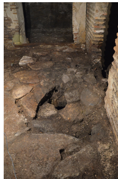
Estructuras no catalogadas
