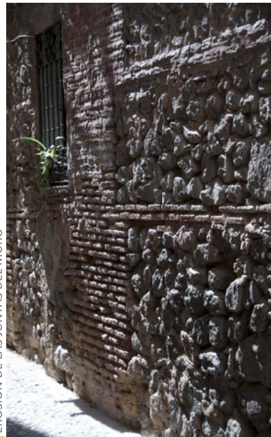
EROSIÓN DE LAS JUNTAS DEL MURO
