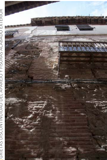
GRIETAS DISCONTINUIDAD DEL APAREJO Y FISURAS ACABADO EXTERIOR
